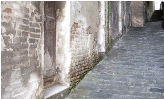
Vernietiging van de mortel- en mortelvoegen
